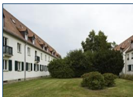
Dresden, Dobritzer Straße
