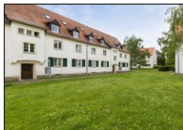
Dresden, Dobritzer Straße
