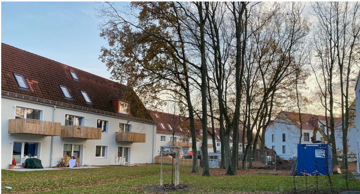
Abbildung 4: Wedel, Blick auf das Areal mit saniertem Bestand und Neubauten
