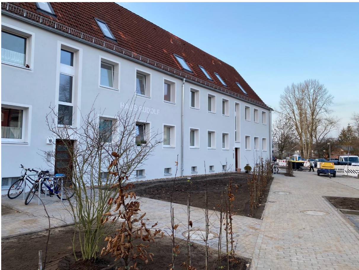
Abbildung 3: Wedel, Am Rain 12, saniertes Bestandshaus
