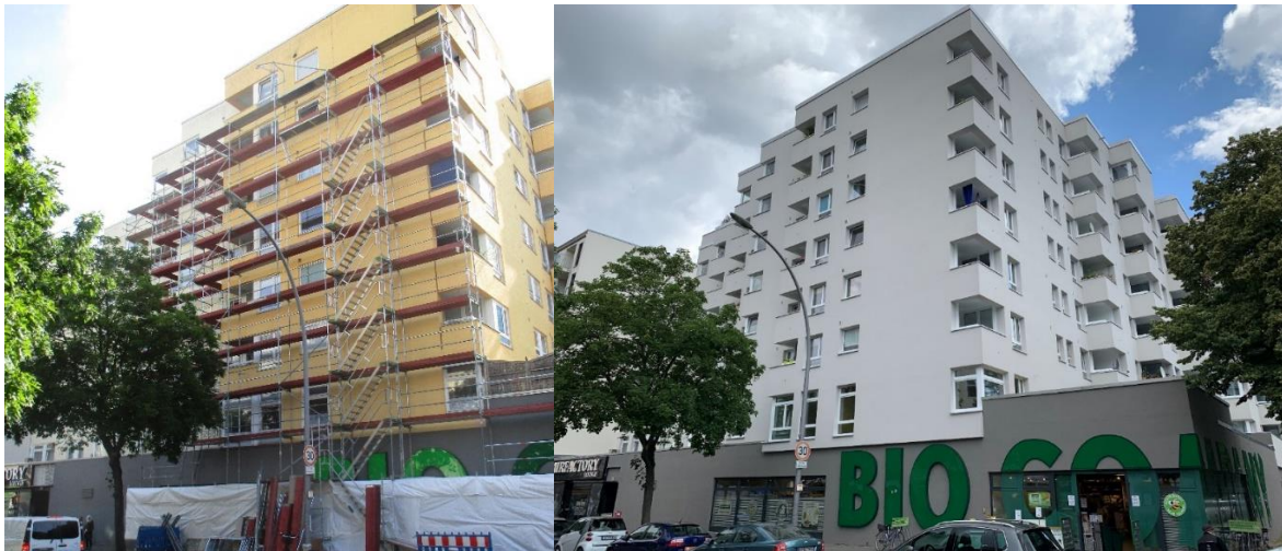
Abbildung 5: Uhlandstraße vor und nach der Sanierung
