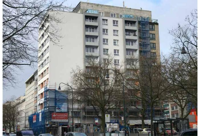
eines Wärmedämmverbundsystems und das Streichen der Fassade. Gleichzeitig werden die leer stehenden Wohnungen saniert. Per Ende Februar 2017 wurden bereits über die Hälfte der Maßnahmen umgesetzt. Bis Sommer 2017 sollen alle Maßnahmen komplett abgeschlossen werden.
