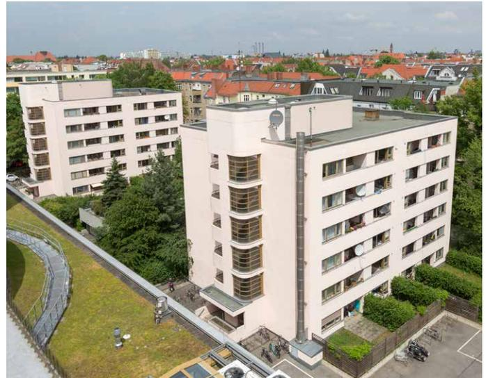
Dachfläche der Schloßstraße 33b. Im Rahmen der Fassadensanierung werden zudem alle Fenster nach gültiger Energieeinsparverordnung ausgewechselt und die Zugangstüren zu den Treppenhäusern, Erschließungsfluren und Fluchtbalkonen erneuert. Für Mitte März 2017 ist die Fertigstellung der Arbeiten an der Schloßstraße 33a geplant. Die restlichen Sanierungsmaßnahmen sollen bis Anfang August 2017 abgeschlossen werden.
