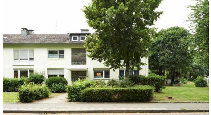
Die Gebäude wurden bereits im Laufe der Jahre saniert. 1990 wurden bei allen Häusern neue Kunststoffenster eingebaut und teilweise ein Wärmedämmverbundsystem auf die Fassaden gebracht. In den Jahren 2002, 2003 und 2009 wurden die Ölheizungen erneuert.
