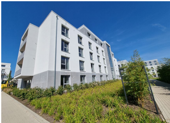
Merianstraße 4 / Baufeld I (65 Wohnungen)
