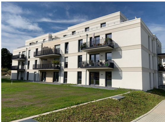
Merianstraße 11 / Baufeld III (28 Wohnungen)
