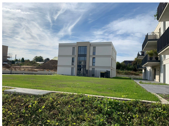
Merianstraße 9 / Baufeld III (9 Wohnungen)
