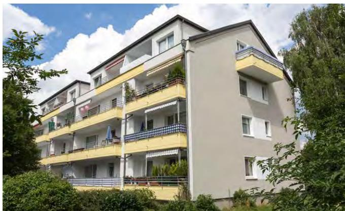
In den letzten 25 Jahren wurden verschiedene Sanierungsmaßnahmen durchgeführt. So wurde 1985 und 1991 ein Wärmedämmverbundsystem aufgebracht und die alten Holzfenster wurden gegen neue Kunststofffenster mit Isolierverglasung ausgetauscht. In den Jahren 1998 und 2002 wurden die Heizzentralen (Ölheizung) erneuert.
