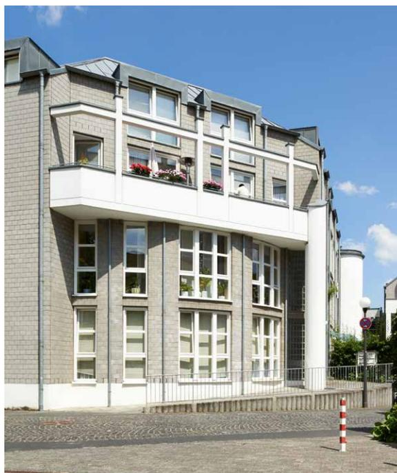
Die Wohnanlage befindet sich in einem guten Zustand und es besteht lediglich in Teilbereichen geringfügiger Sanierungsbedarf. Mittelfristig ist vorgesehen, die Instandsetzung der Dachflächen, der Tiefgarage und der Treppenhäuser vorzunehmen.
