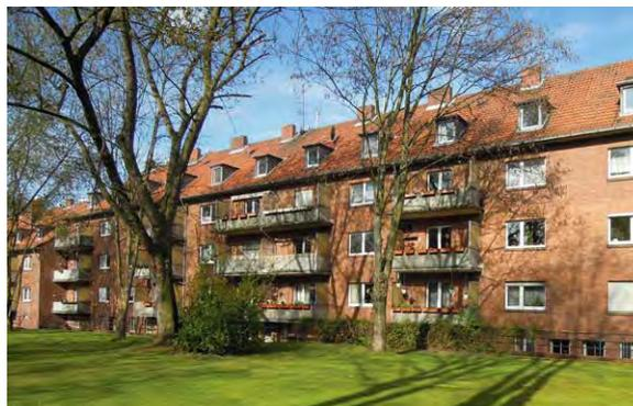
Für die Mehrfamilienhäuser in der Kapfenberger Straße wurden eine partielle Fassadensanierung, die Kellerdeckendämmung und die Dachsanierung der Häuser 9–11 und 19–21 sowie der Garagen durchgeführt. Darüber hinaus wurden die Strangsanierung und die Treppenhaussanierung in allen Häusern sowie die Erneuerung der Heizzentralen in den Häusern Nr. 5 und 19–21 vorgenommen.
