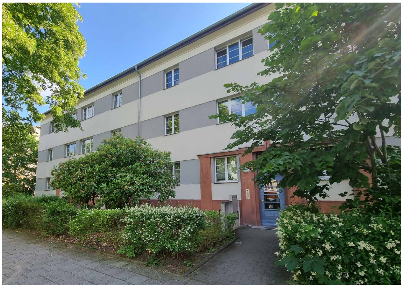
„Borthener Straße“, Dresden, Deutschland
